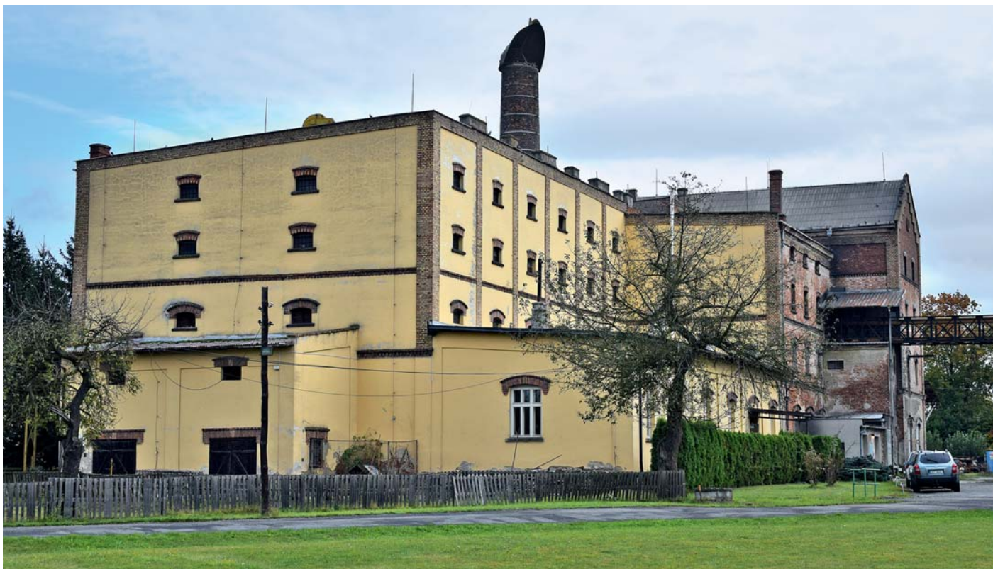
Obr. 11 Pohled na sladovnu v roce 2016 (zdroj: Milan Starec, 2016)
